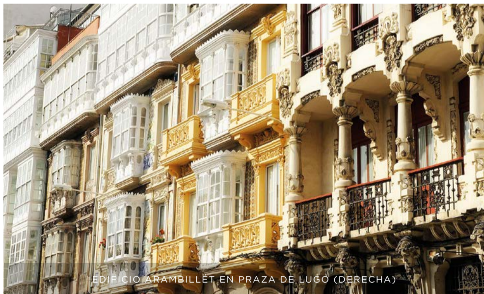
DETALLE FACHADA DE PRAZA DE LUGO
