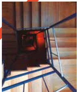
Escaleras de acceso a las plantas.
