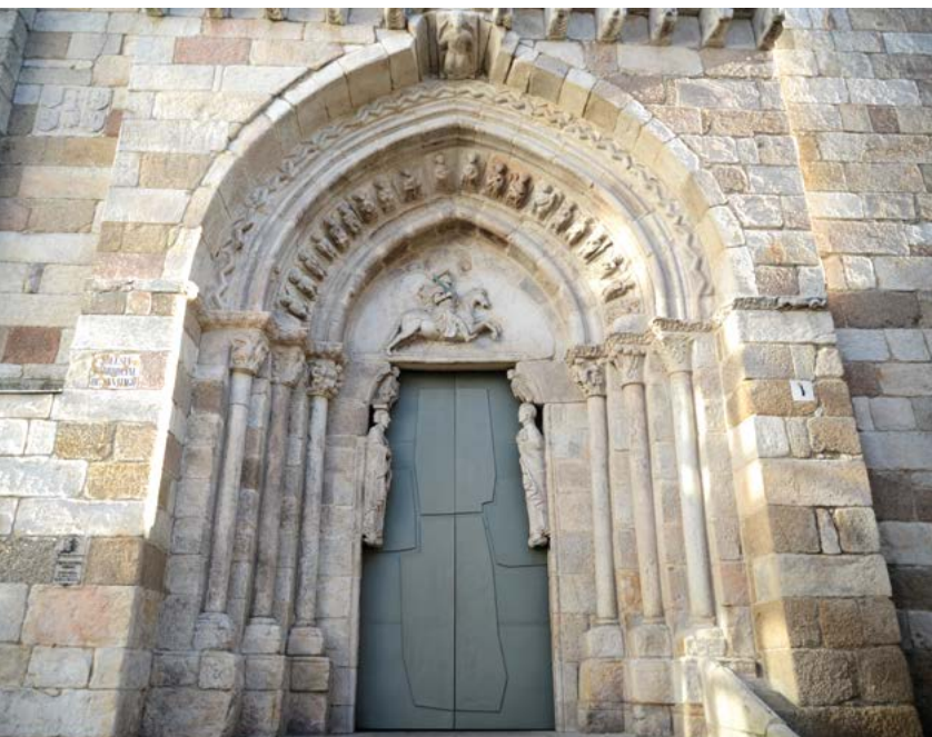
Portadas occidental, foto 1 y 2, y lateral, foto 3, de la Iglesia de Santiago
