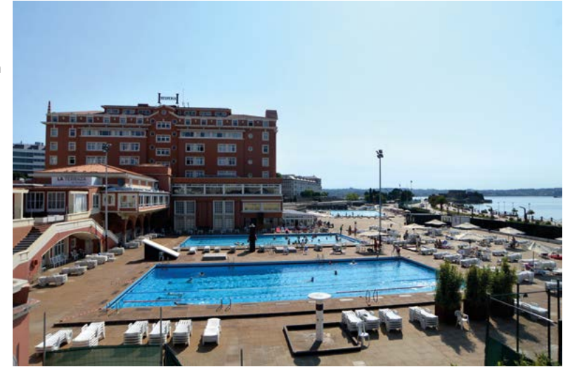
Área del perdido puerto de O Parrote. Al fondo, el hotel Hesperia Finisterre
