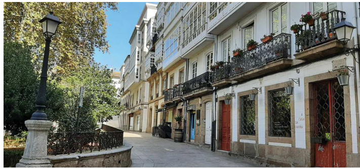
Fig. 48. Cantón de Azcárraga. Estado actual. Foto del autor.
