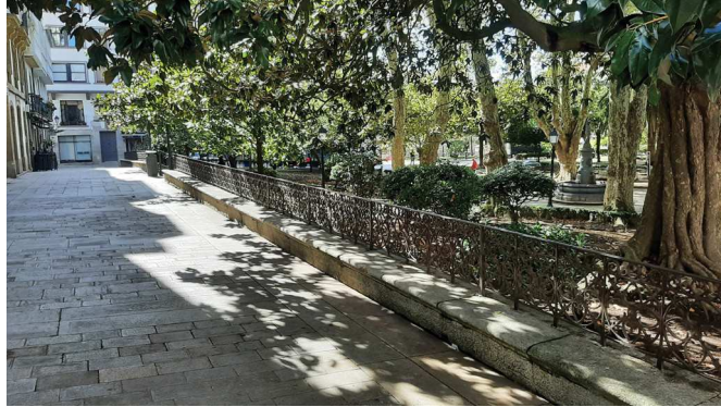
Fig. 47. Cantón de Azcárraga. Estado actual. Foto del autor.
