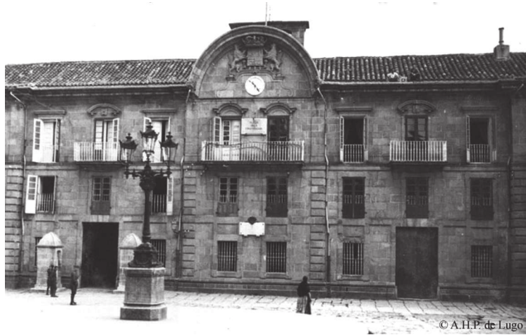
Fig. 51. Fachada principal del Palacio de Capitanía (detalle). Ca. 1910. Archivo Histórico Provincial de Lugo (AHPL), Colección fotográfica. 16042.
